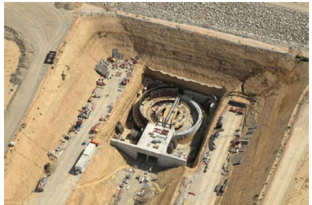
Detalle de la zona de ubicación de las compuertas de la toma de fondo.
