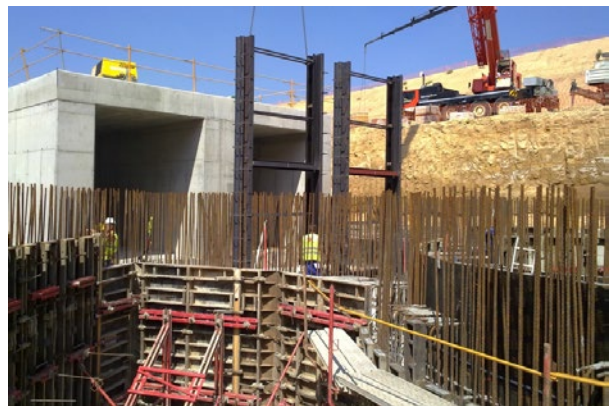
Instalación de los marcos de las compuertas.
